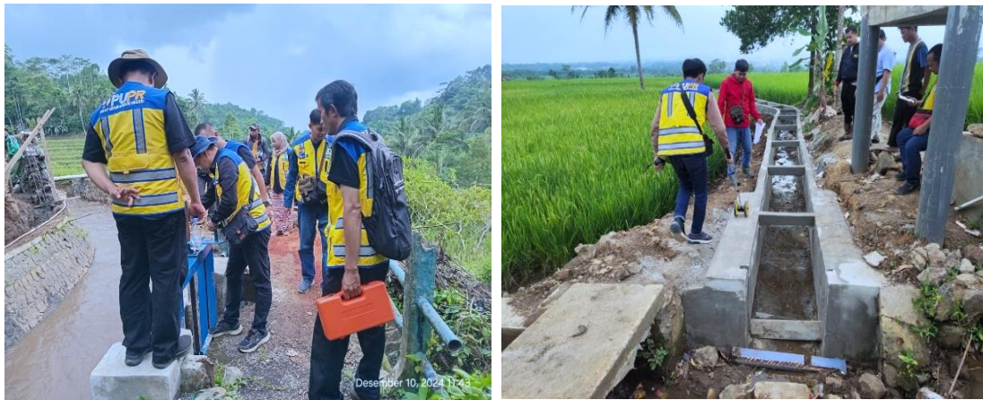
Gambar 3.2. Kegiatan Rehabilitasi Jaringan Irigasi Kabupaten Tasikmalaya Tahun 2024
