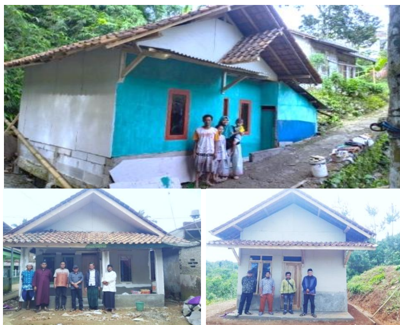
Gambar 3.7. Kegiatan Rehabilitasi Rumah Tidak Layak Huni Kabupaten Tasikmalaya Tahun 2024
